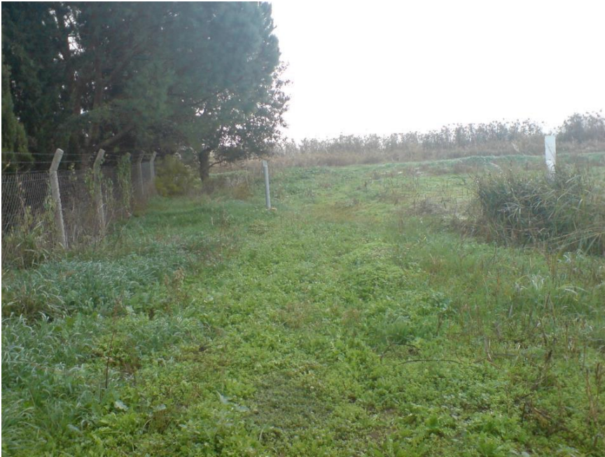
Boru hattı inşaatı sonrası
