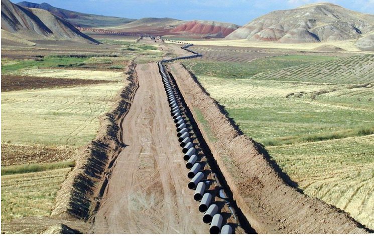
Boru Hattı İnşaatı
